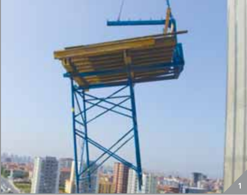
Masa Kalıp Uygulaması
