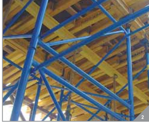
Ağır Yük Kule Uygulaması
