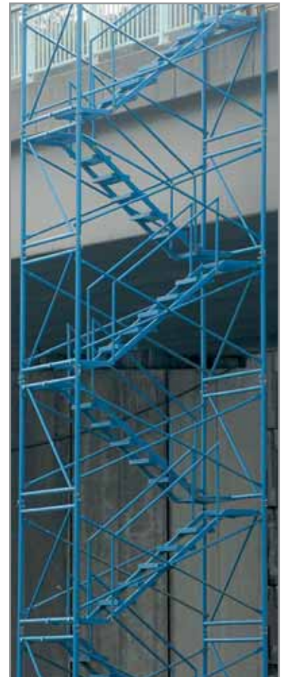
Merdiven Kulesi Uygulaması
